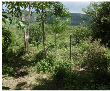
Construction de la clôture de l'école Sena
